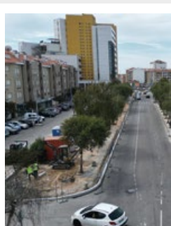
Início da obra de requalificação da Rua Dr. Mário Sacramento pág.17
