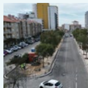
pág.17 Início da obra de requalificação da Rua Dr. Mário Sacramento
