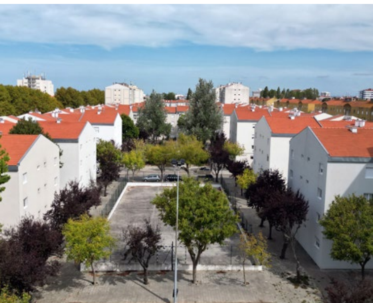
Intervenção em curso na urbanização de Santiago
