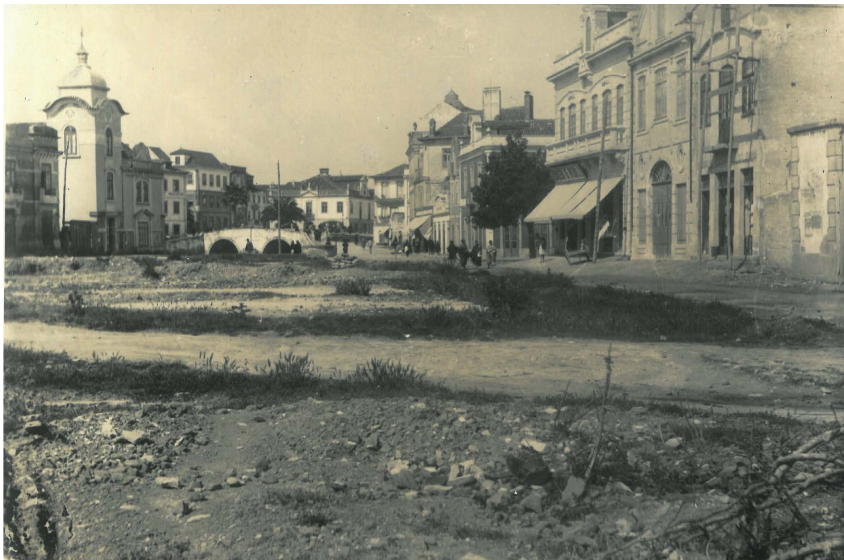
Aveiro. Construção da Avenida Central. 1926 Museu da Cidade de Aveiro / Imagoteca
