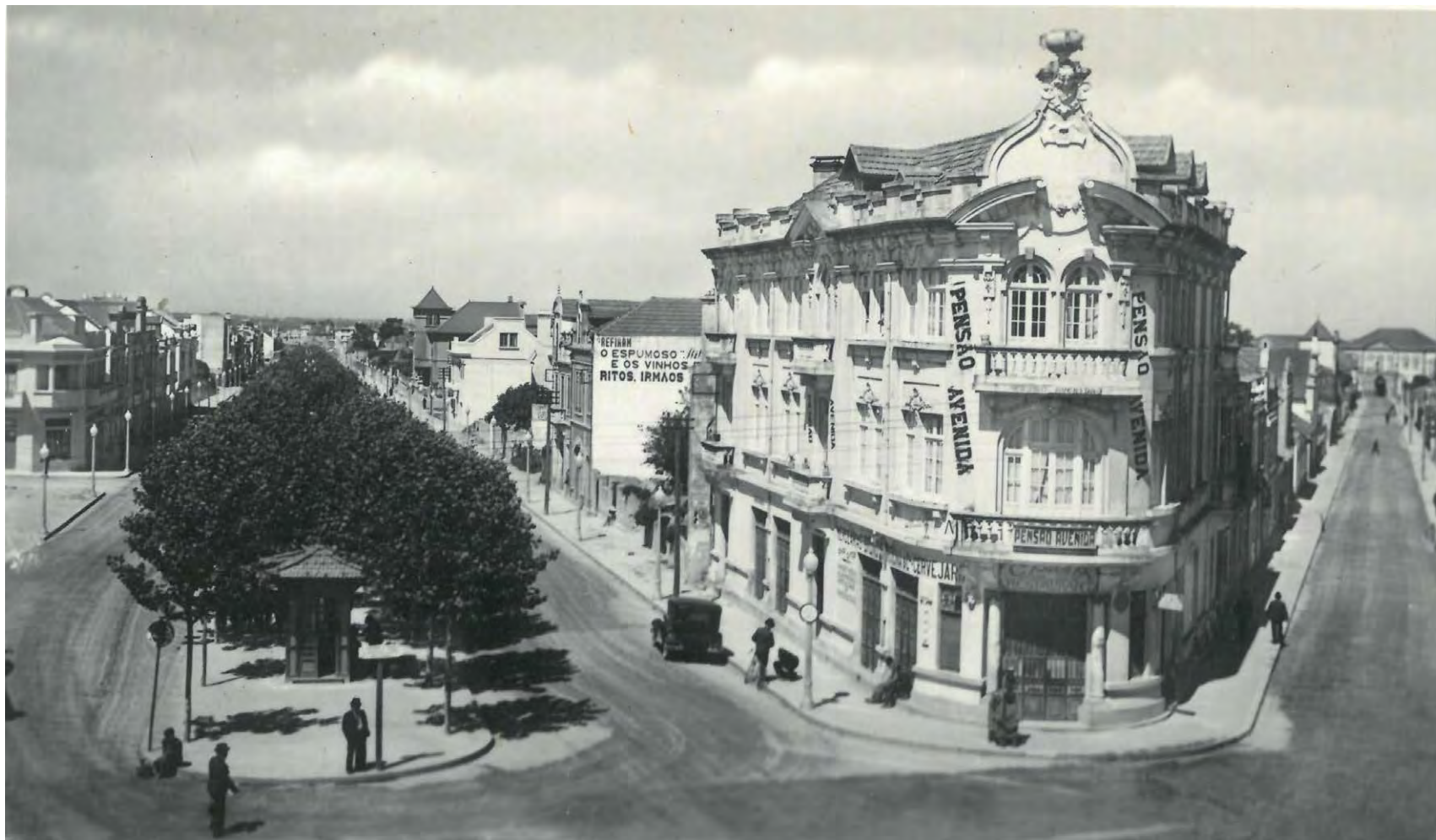
Pensão Avenida. Avenida - nascente. 1940
