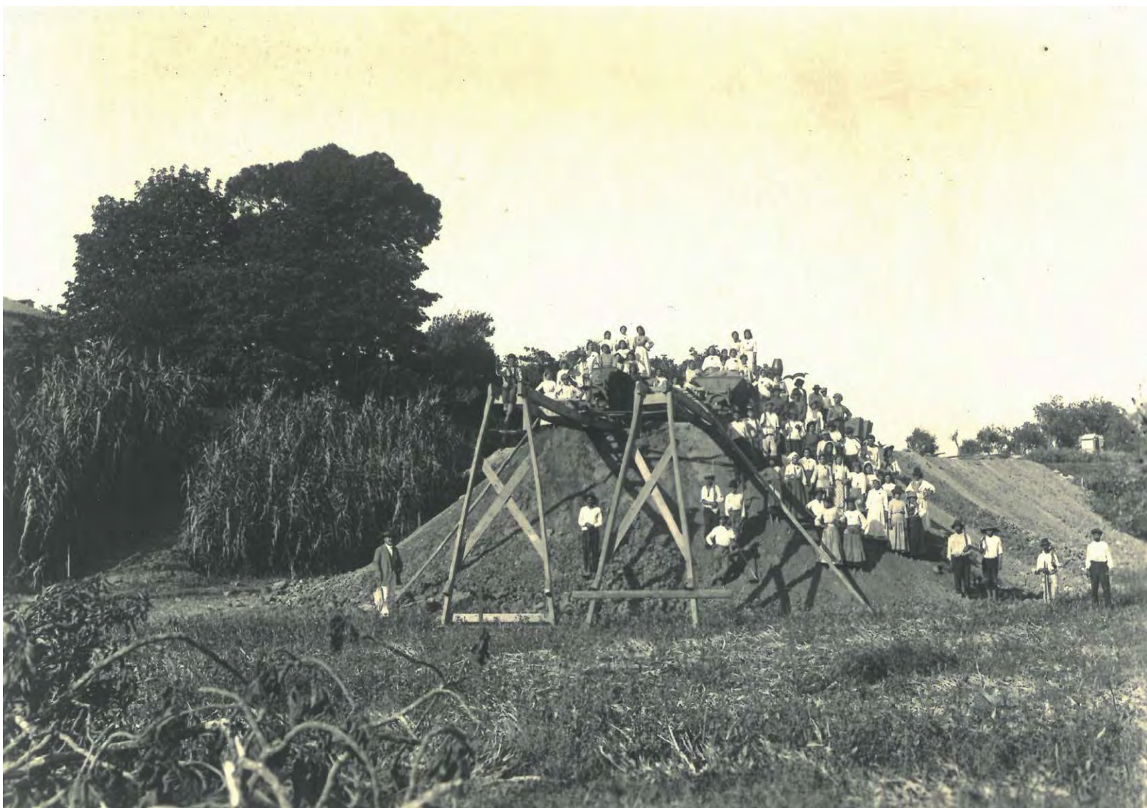
Aspeto de um aterro para a construção da Avenida Central. 1919 Museu da Cidade de Aveiro / Imagoteca
